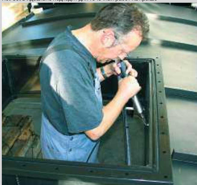
DIODE S используется при сварке деталей на баке
