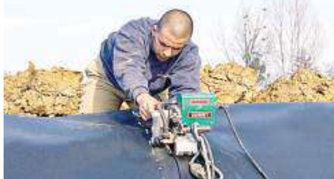
... на обустройстве полигона
