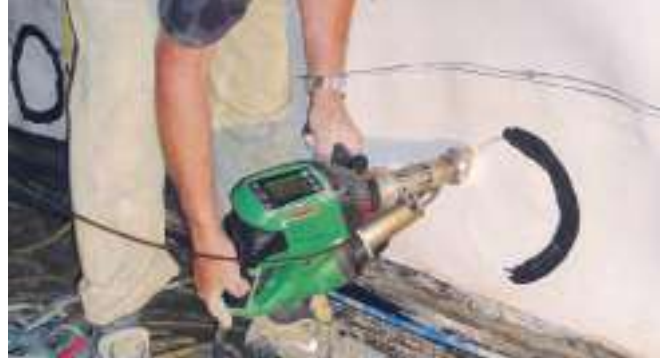
Прочный WELDPLAST S2 при сварке заплатки в туннельном строительстве
