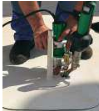
TRIAC DRIVE сваривает как на горизонтальных поверхностях,...
