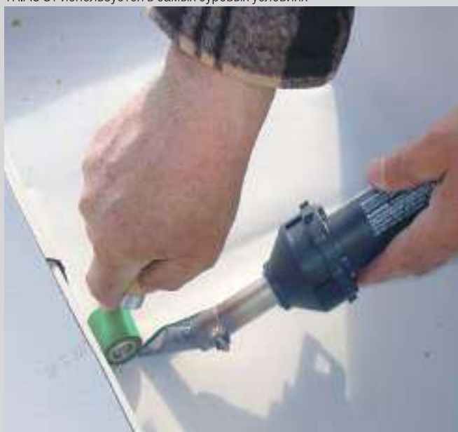
Hot-Jet S идеально подходит для точечных работ на крыше
