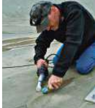
Сварка стыков при помощи TRIAC AT и щелевой насадки
