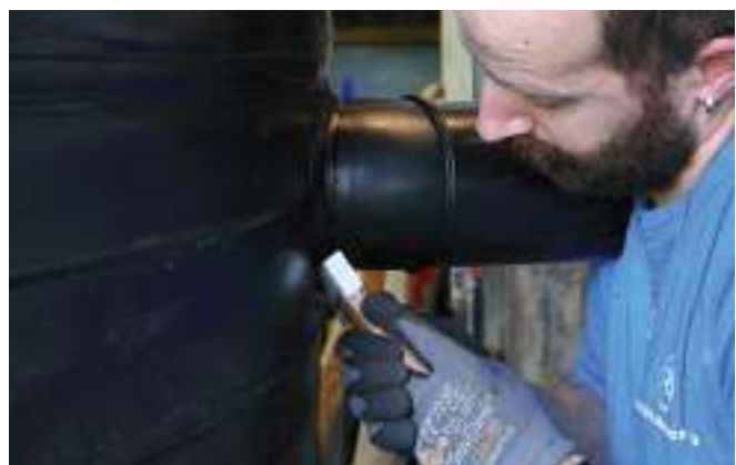
Использование прессинструмента для экструзионной сварки в труднодоступных местах
