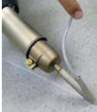
Сварка напольных покрытий ручным аппаратом TRIAC ST
