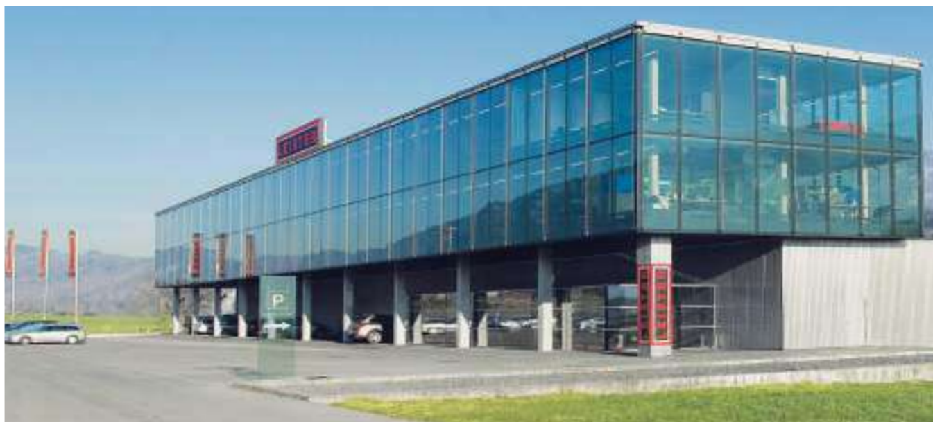
Leister Technologies AG, корпоративный центр, Кегисвиль, Швейцария
