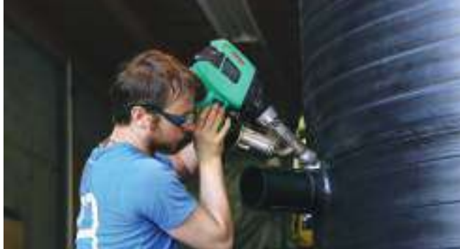
Удобный WELDPLAST S2 в работе
