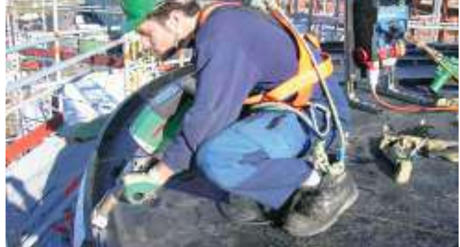
Мощный Weldplast S4 в работе
