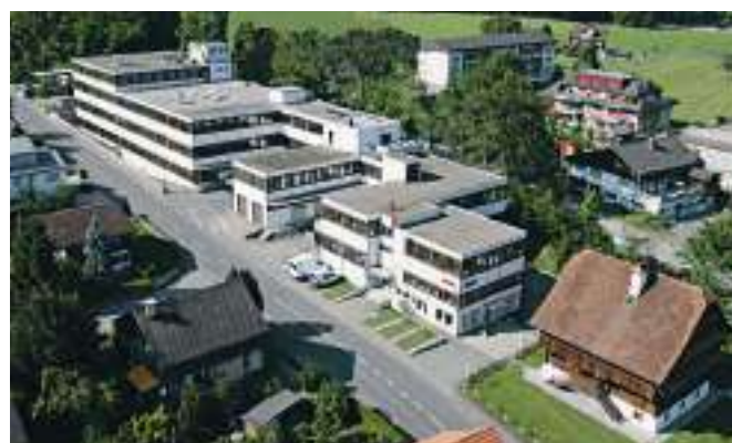
Leister Technologies AG, производственное здание, Кегисвиль, Швейцария
