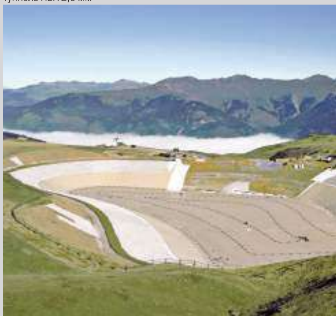
Водохранилище ПВД 2,0 мм
