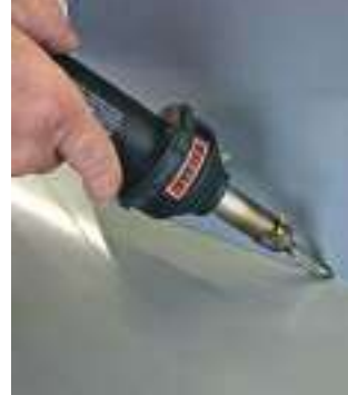
Фиксация свариваемых листов с помощью насадки для прихватки
