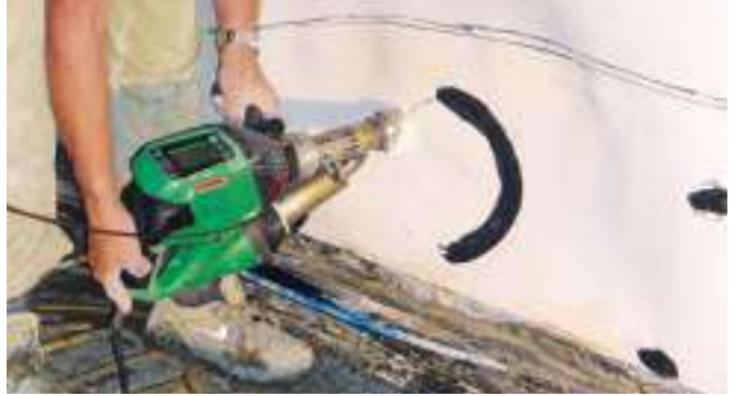
Удобный и надёжный ручной сварочный экструдер WELDPLAST S2 при работе в туннелях
